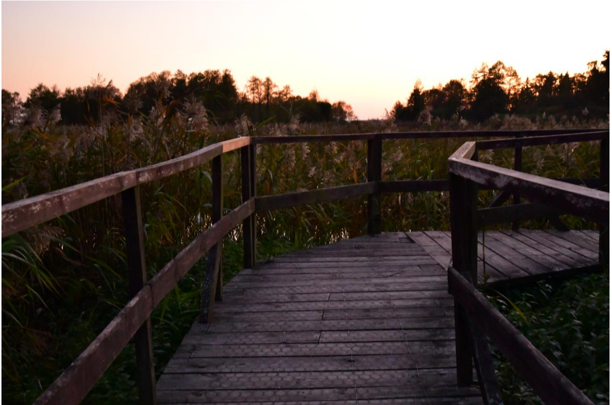
Istniejąca Kładka w Kurowie przeznaczona do rozbiórki
