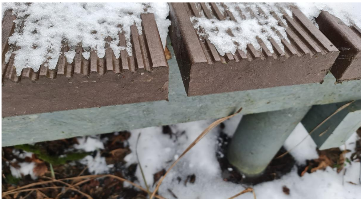
Zdj.3. Widok poglądowy kładki w Wigierskim Parku Narodowym – zastosowanie materiału kompozytowego na podesty, kładki, platformy i poszycie ścieżek
