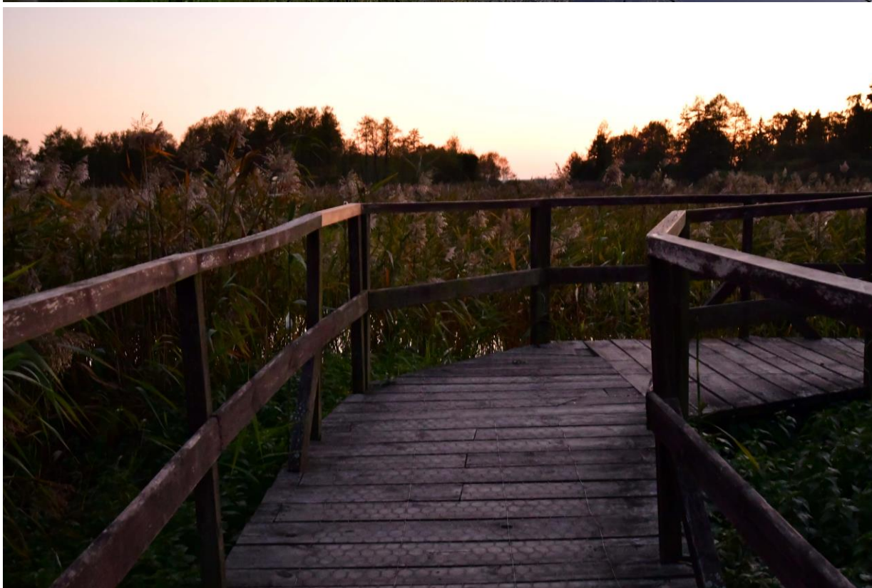
Kładka przeznaczona do rozbiórki
