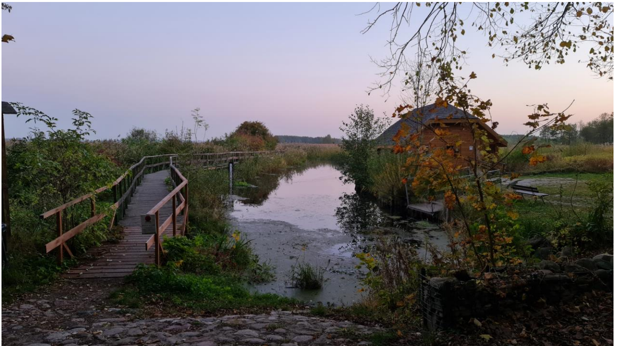
Wejście na istniejącą Kładka przeznaczona do rozbiórki
