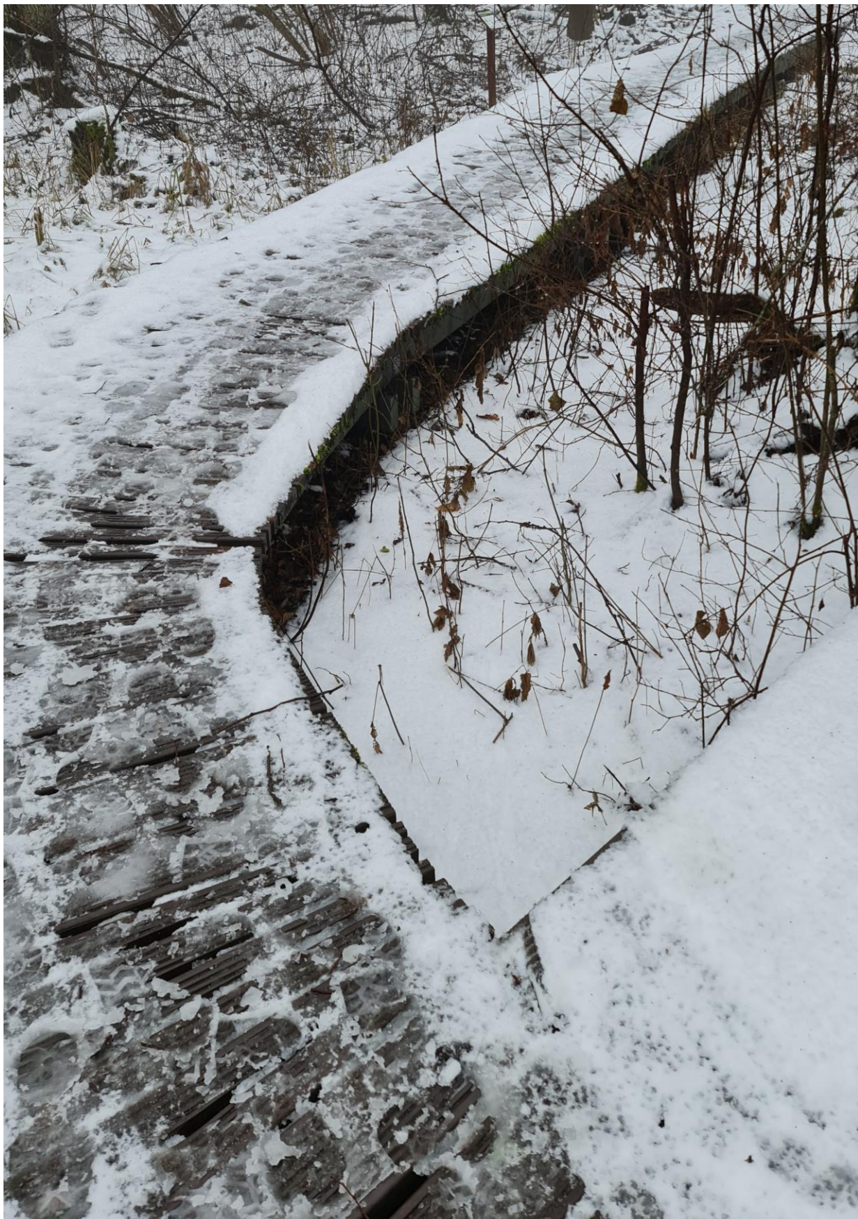
Zdj.5. Widok przykładowy zrealizowanej kładki do 50 cm wysokości w Wigierskim Parku Narodowym – zastosowanie materiału kompozytowego na ławki
